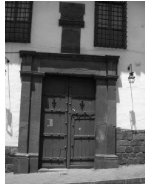
Fig. 4.- Frontis lateral de la antigua calle Coca.
