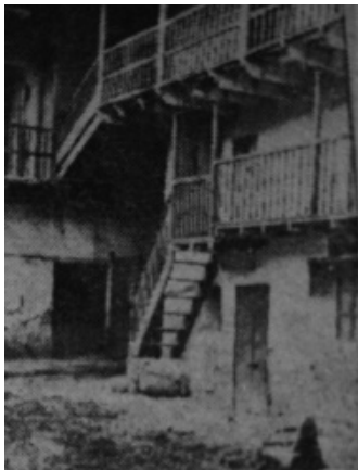
Fig. 5.- Patio de la Casa Garcilaso, antes de su restauración.
