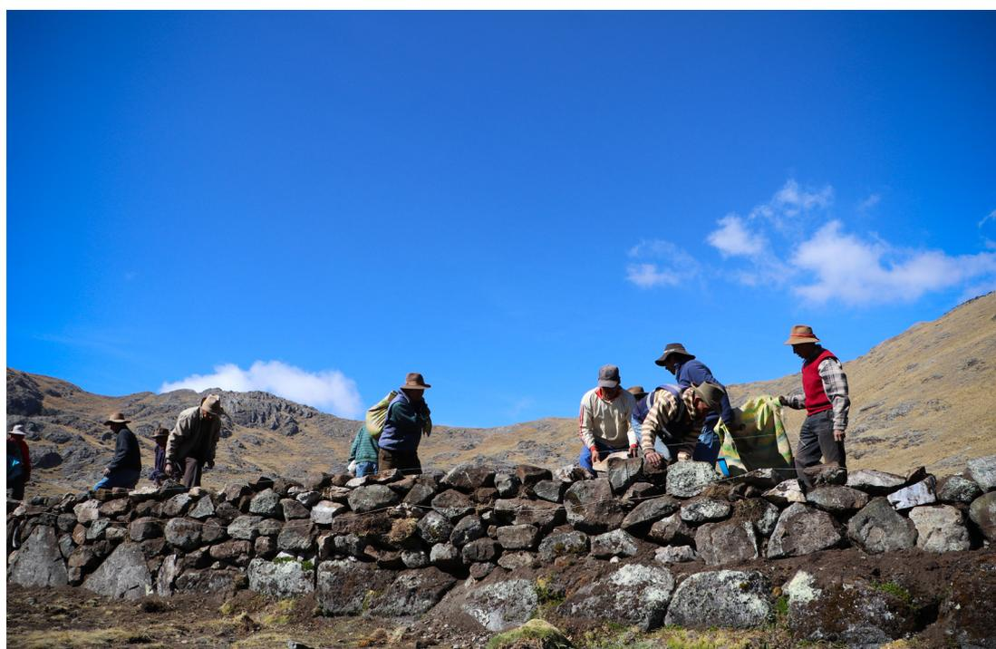
Construcción del talud interior del dique en base a piedras y rocas.
